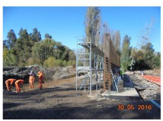
Atravieso 13, Dm 36.874, colocación de armaduras y moldes metálicos de elevación de muro lado Poniente y parte de armaduras en zapata de fundación del muro Oriente.
