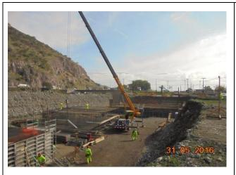
Viaducto de San Felipe, en primer plano fundación Estribo de entrada, listo para ser hormigonada, además armaduras de zapata de los muros laterales 1 y 3, ubicados en el lado izquierdo próximo al estribo.
