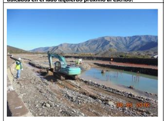
Puente de Las Tinajas, Se ejecutaron trabajos de excavaciones con agotamiento en el estribo de entrada y cepas para descubrir cabezas de pilotes.
