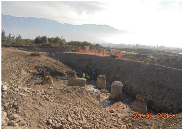
**Puente de Las Tinajas, Continuó el agotamiento de agua y excavación en el estribo de salida del puente, para iniciar las faenas de descabezado de los pilotes.**
