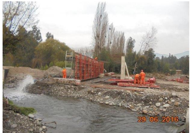
**Atravesio 13, Dm 36.874, Muro poniente terminado, se colocaron armaduras y moldes metálicos de elevación de muro lado Oriente.**
