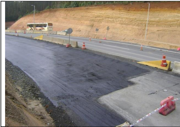
Imprimación Base Tramo A Sector II By Pass Laraquete Lado Derecho Pistas 1-3 km: 43,250 – 43,400; Eje N°36 Lado izq/der km: 0,000 – 0,100
