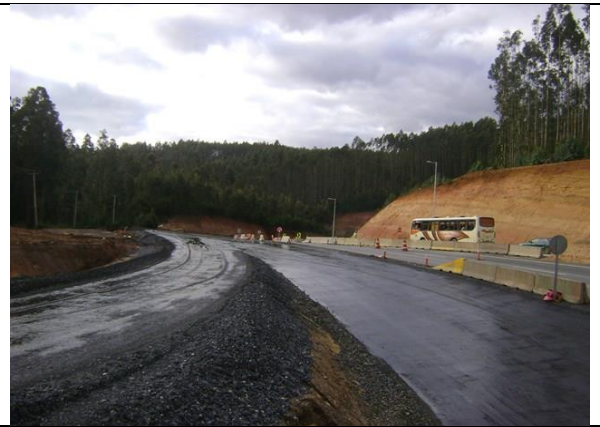
Imprimación Base Tramo A Sector II By Pass Laraquete Lado Derecho Pistas 1-3 km: 43,250 – 43,400; Eje N°36 Lado izq/der km: 0,000 – 0,100
