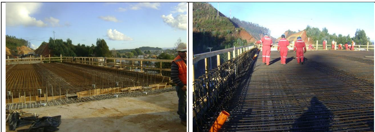
Instalación de Enfierraduras Losa Superior Vano N°2 Tramo A Sector II Viaducto las Cruces Lado izq. /der km: 44,384,25
