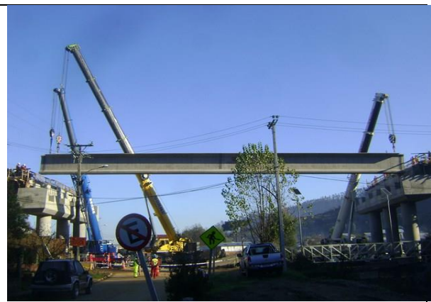
Instalación Viga 1 (Vano N° 3), entre Cepa N°3 y Cepa N°4 Tramo A Sector II By Pass de Laraquete Viaducto las Cruces Lado izq/der km: 44,429,40
