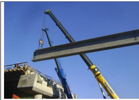
Instalación Viga 1 (Vano N° 3), entre Cepa N°3 y Cepa N°4 Tramo A Sector II By Pass de Laraquete Viaducto las Cruces Lado izq/der km: 44,429,40
