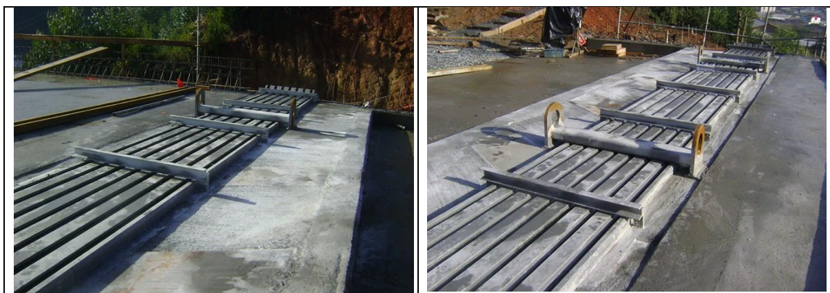
Instalación Juntas de Dilatación Estribo de salida Viaducto las Cruces Tramo A Sector II By Pass Laraquete Lado izaq/der km: 44,454,404
