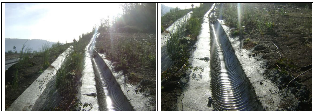
Instalación Bajadas de Aguas Iluvias Tramo A Sector II By Pass de Laraquete Lado Izquierdo km: 45,300
