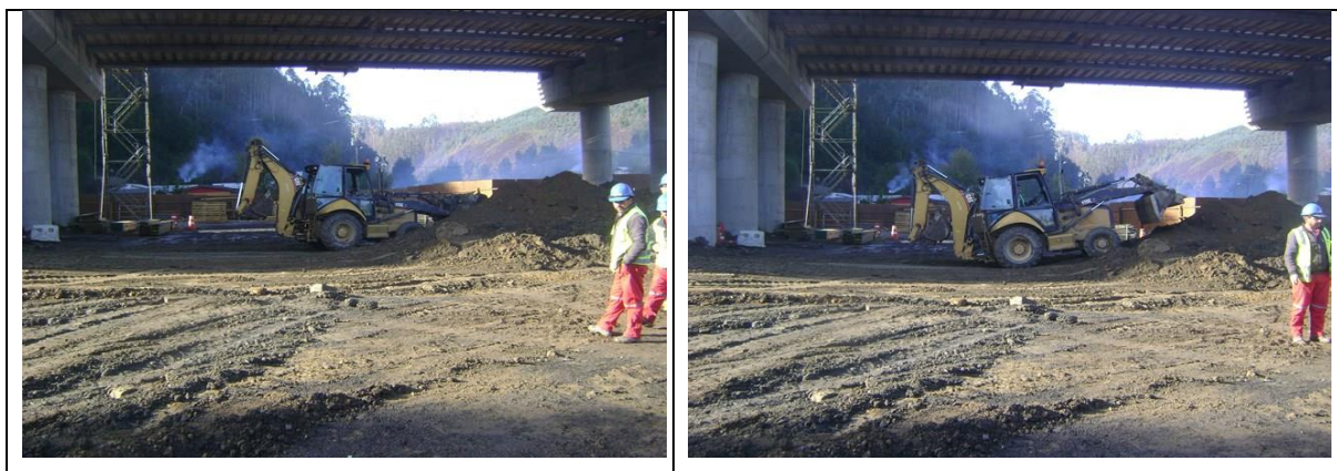
Preparación Plataforma Instalación de Grúas entre Cepa N°1 y Cepa N°3 Viaducto las Cruces Tramo A Sector II By Pass de Laraquete km: 44,353,1
