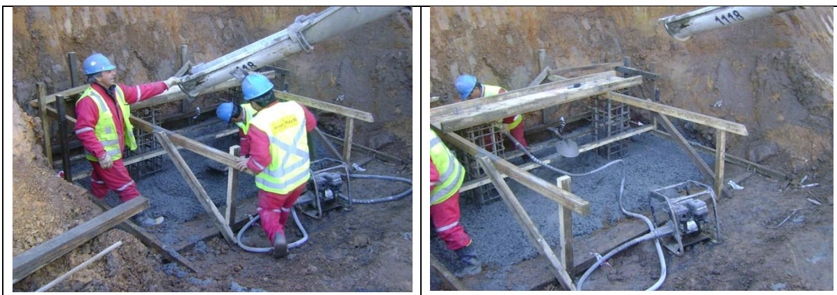
Hormigonado de Fundación Pórtico Señal Tramo A Sector II By Pass de Laraquete Lado Derecho km: 43,220
