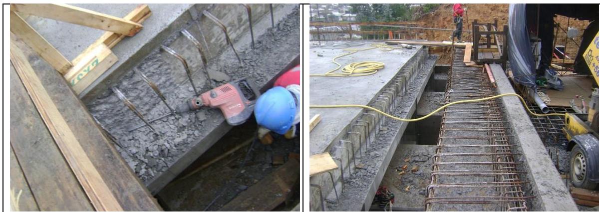
Preparación para Colocación Juntas de Dilatación Estribo de Salida Viaducto las Cruces Tramo A Sector II By Pass Laraquete Lado izq/der km: 44,454,404
