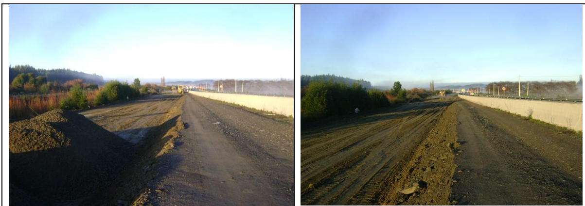
Preparación de la Subrasante Tramo A Sector II Lado Izquierdo km: 58,420 – 58,500
