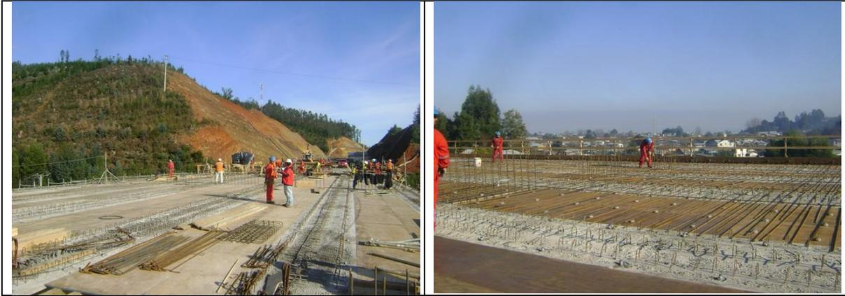
Instalación de Enfierraduras Losa Superior Vano N°3 Tramo A Sector II
