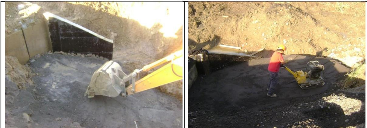
Compactación relleno estructural de Cajón Prefabricado O. Arte N° 75 ala
