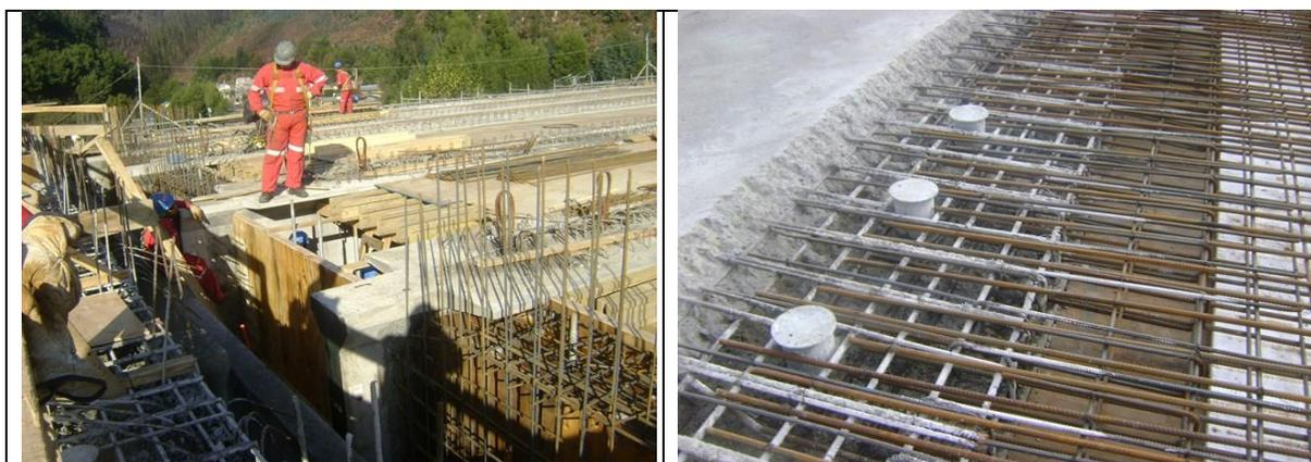
Instalación de Barras Antisísmica entre Vano N°2 y vano N°3 Tramo A Sector II Viaducto las Cruces Lado izq. /der km: 44, 384,25
