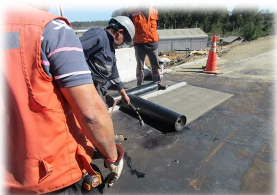
Colocación de membrana impermeable en losa de estructura Paso Superior Laraquete Sur.
