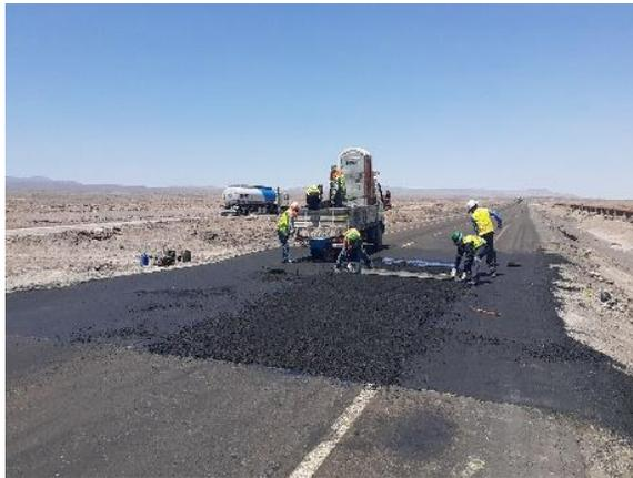
Foto N° 3 Vista de reparación de calzada en Ruta 25
