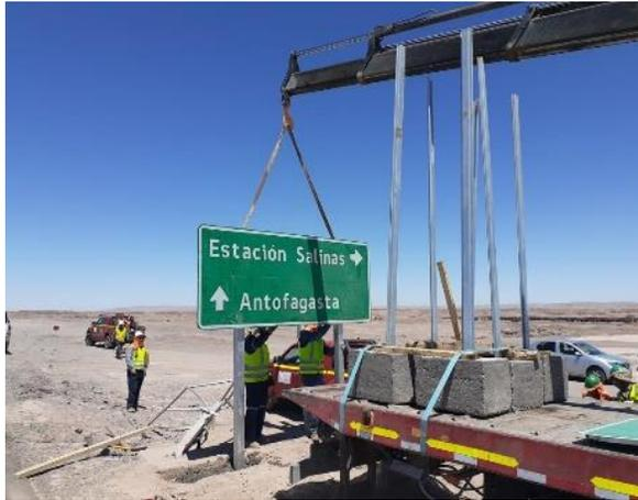
Foto N° 1 Reposición de Señalización en Ruta 25 (Dm. 3.960)
