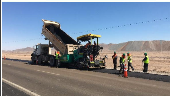
Foto N° 04 Trabajos de reparación de baches en Ruta 25
