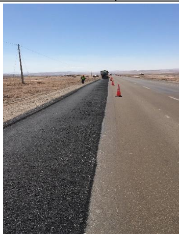
Foto N° 03 Trabajos de reparación de baches en Ruta 25
