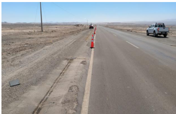
Foto N° 05 Reparación de "baches" en berma Ruta 25
