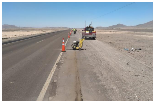
Foto N° 06 Reparación de "baches" en berma Ruta 25
