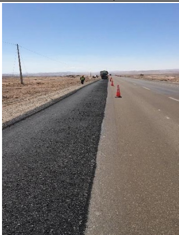
Foto N° 03 Trabajos de reparación de baches en Ruta 25
