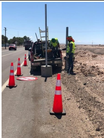
Foto N° 01 Trabajos de reparación de señalización (Dm. 107.800 de Ruta 25)
