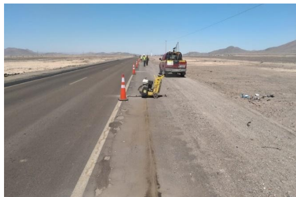
Foto N° 06 Reparación de "baches" en berma Ruta 25
