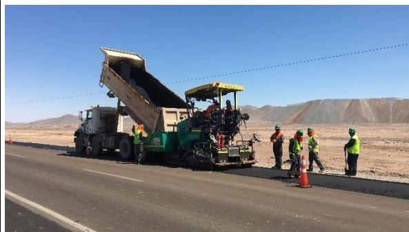
Foto N° 04 Trabajos de reparación de baches en Ruta 25
