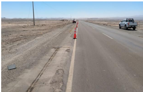
Foto N° 05 Reparación de "baches" en berma Ruta 25
