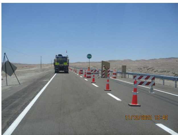
Foto N° 05 Esquema de señalización para angostamiento de pista
