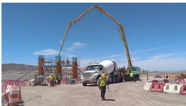
Foto N° 03 Hormigonado de columnas Paso Inferior Acceso Sur Sierra Gorda
