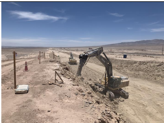
Foto N° 01 Trabajos de Corte en TCN en km 93.400
