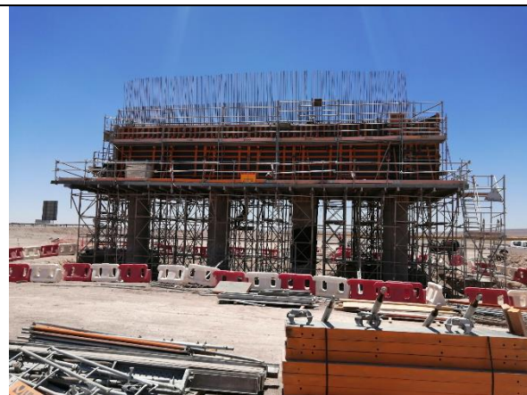
Foto N° 02 Armado y colocación de enfierradura Paso Inferior Carmen Alto.
