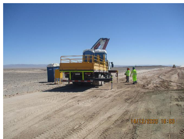
Foto N° 06 Instalación de baños químicos en distintos puntos de trabajo.
