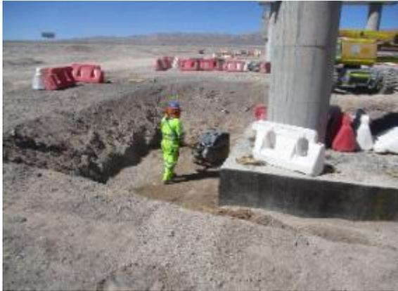
Foto N° 03 Enlace Dupont: Relleno estructural de fundaciones
