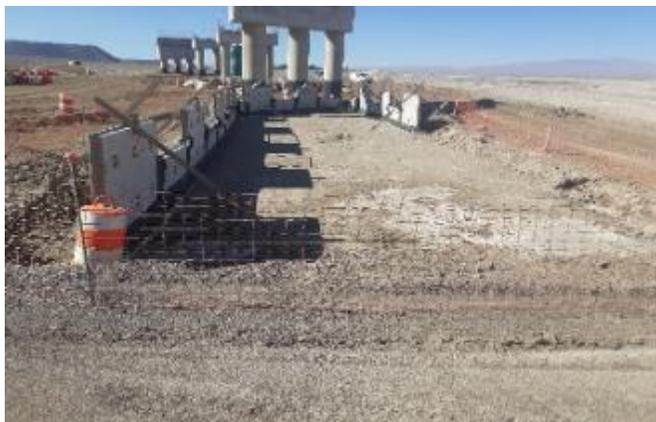
Foto N° 05 Enlace Acceso Sur Sierra Gorda: Ejecución 1° capa formación y compactación terraplén muro TEM
