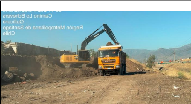
Excavación escarpe Subsector B2
