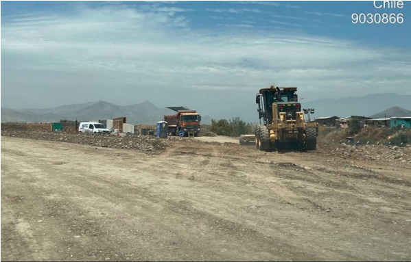
Conformación terraplen en Subsector B3
