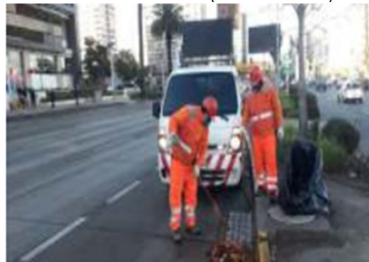
Limpieza de sumideros.
