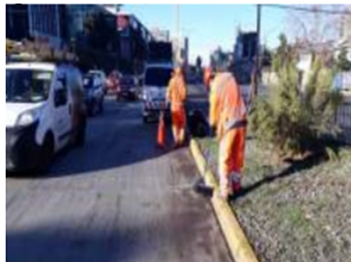
Limpieza calzadas y soleras.
