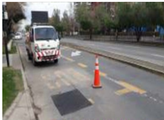
Mantención de Calzadas (Bacheo Asfáltico).
