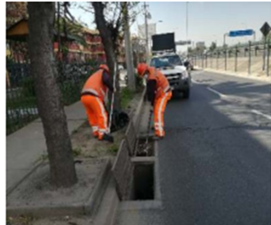
Limpieza de sumideros.
