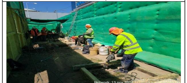
Tramo 3 Edificio Corporativo: Se inició la excavación manual de Pilas proyectadas para el socialzado
