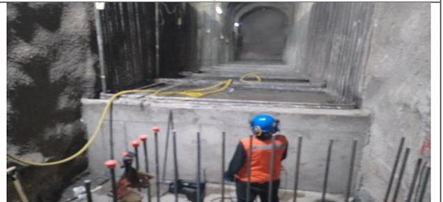
Frete 8 Túnel Alemán: Hormigonado de hastial hasta nivel Z1, desde pilotes E24 al E13
