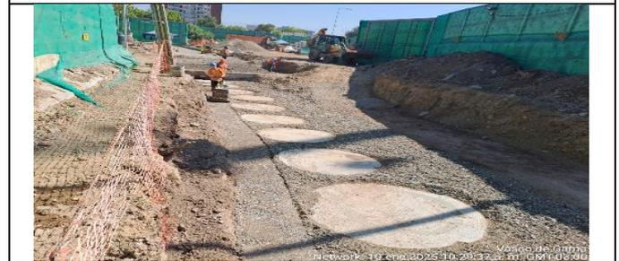
Tramo 3: Reposición de calle Exequiel Figueroa entre E. Castillo V. y Pedro Rico: Se termina el corte de los 30 Pilotes.
