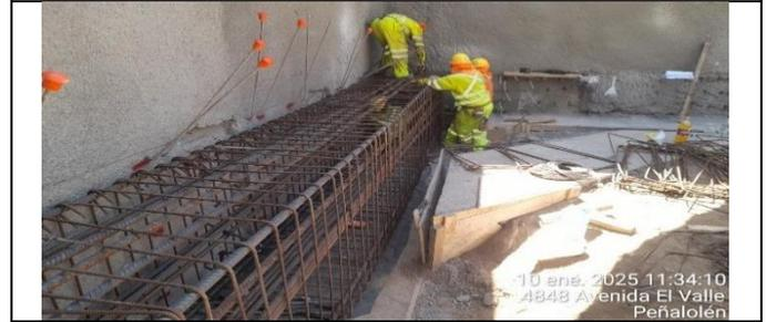
Frente 6, Escotilla Vespucio Sur: Instalación de armadura Viga de Apeo, sector B2
