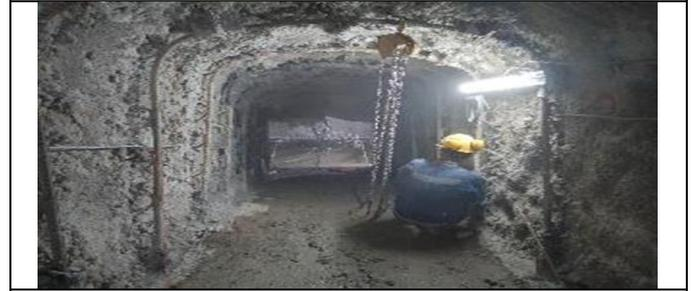
Frente 8 Túnel Alemán Galería clave túnel alemán, se terminan cortes con hilo diamantado en costilla C40.
