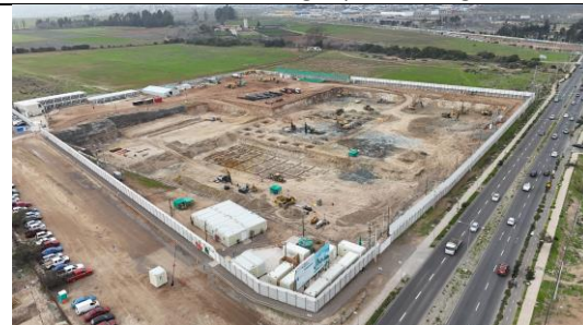
Vista aérea desarrollo de la obra
