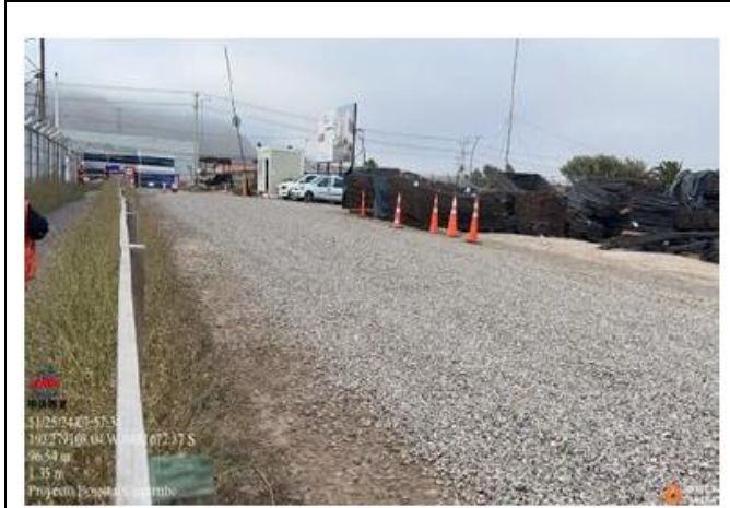
Humectación y preparación de caminos de la obra
