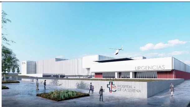
Fachada sur, acceso principal a urgencias y CAE.
