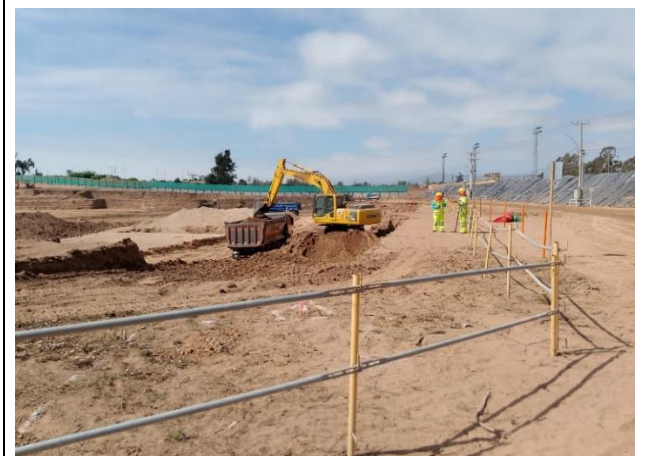
Movimiento de Tierra (sector Oriente de la excavación)
