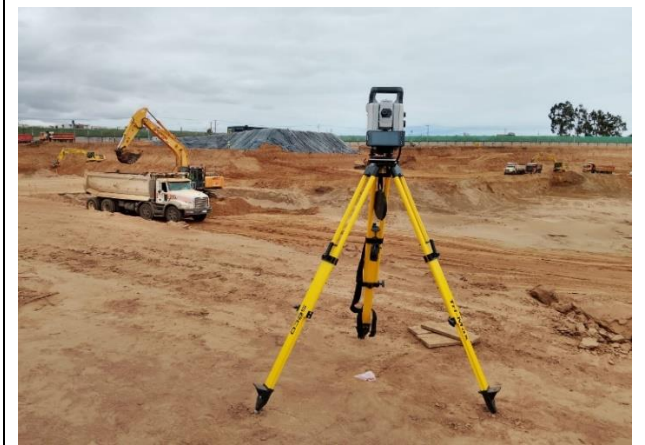
Replanteos Topográficos en Excavación Masiva
