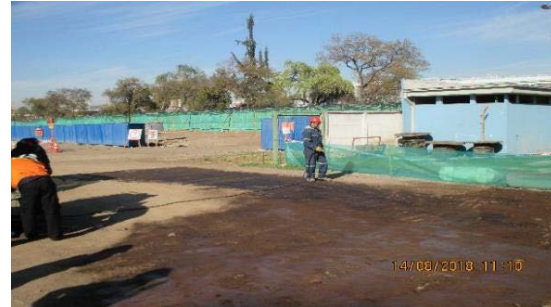
Humectación terreno acceso de vehículos
