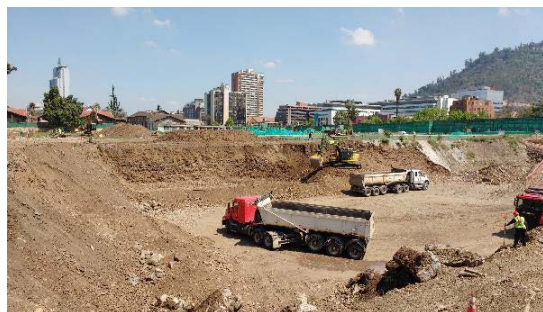
Reinicio de excavaciones sector oriente terreno
