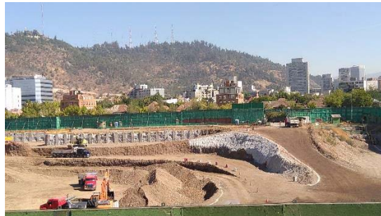
Excavaciones sector oriente terreno
