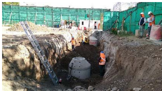
Instalación de alcantarillado
