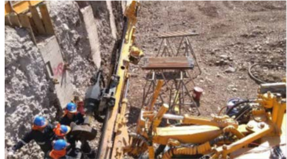
Perforación de anclajes en pilas de entibación
