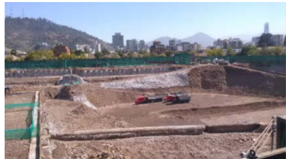
Excavaciones zona norte del terreno
