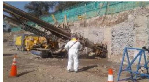
Perforación de anclajes en pilas de entibación
