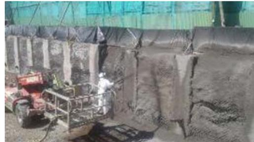
Aplicación de shotcrete muros entre pilas
