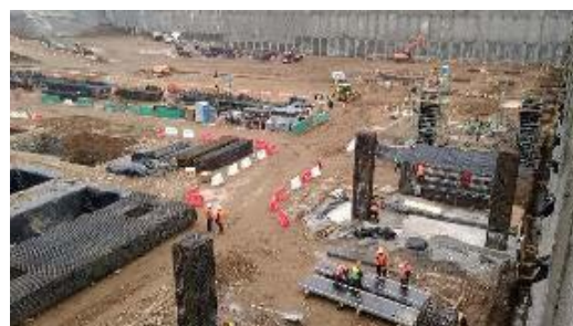
Vista general área de construcción en sector ING
