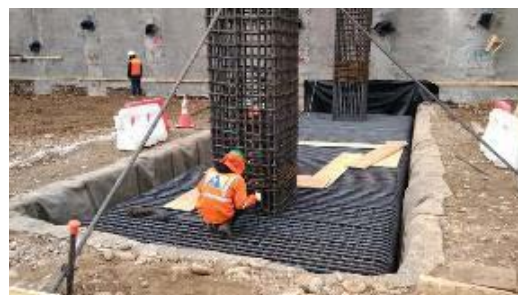
Instalación de enfierradura de fundación y pilares
