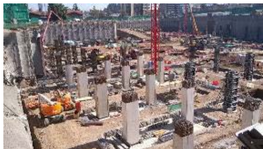
Vista general pilares de fundación en sector ING
