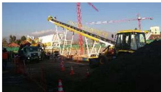
Instalación de Planta de Hormigón Premezclado
