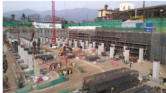
Vista general pilares de fundación en sector ING
