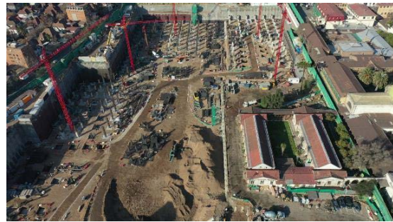
Foto aérea con vista general de la obra
