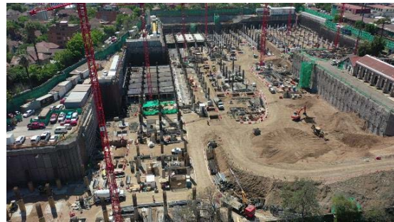
Foto aérea con vista general de la obra Hospital Salvador
