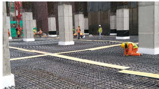
Confección enfierradura de losa edificio ING
