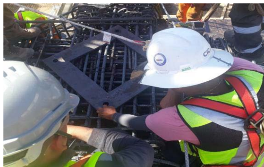
Pruebas posicionamiento de aisladores sísmicos
