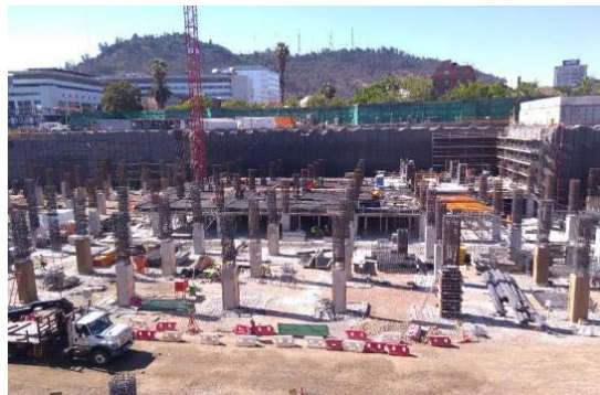
Vista general avance de la obra Hospital Salvador
