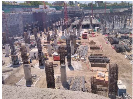
Vista general avance de la obra Hospital Salvador
