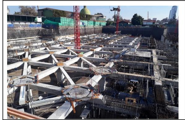
Avance en ING, Instalación de vigas metálicas diagonales
