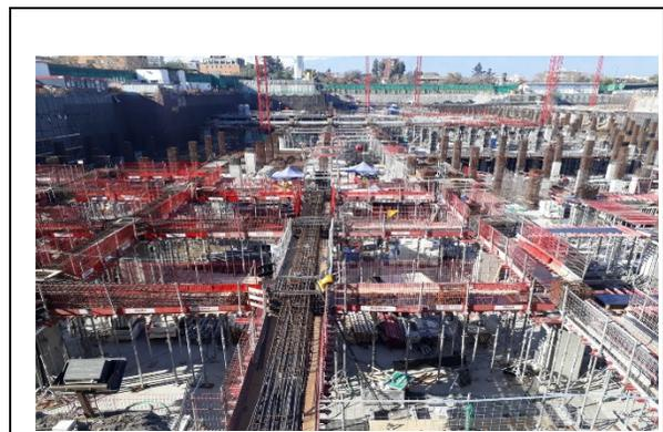
Instalación de armadura y moldaje para vigas del nivel -2 en área Atención Abierta
