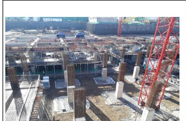
Preparación de armadura y moldajes para vigas en hormigón en HDS
