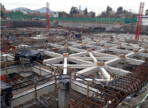
Sector ING. Avance en instalación de moldaje, armadura para vigas, muro en hormigón perimetral, instalación de aisladores y Vigas en acero. Nivel -2 bajo aisladores
