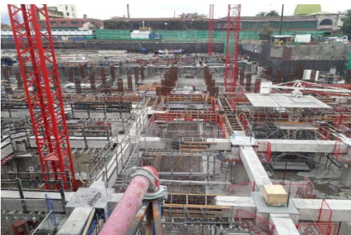
Sector HDS. Avance en instalación de moldajes para vigas en hormigón nivel -2. Bajo aisladores
