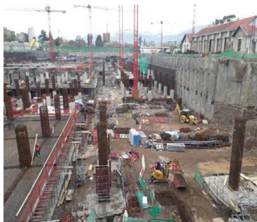
Sector AA. Excavación de fundaciones para pilares. Armadura de pilares y losa de cielo del nivel
