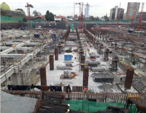
Sector HDS. Losa de cielo nivel -3 y armadura de pilares nivel -2.
