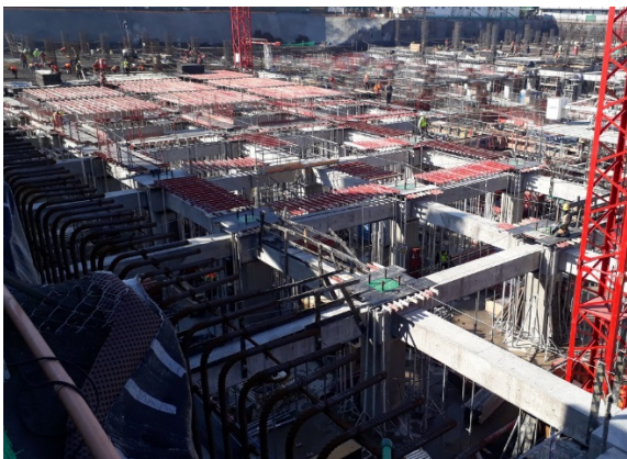
Sector HDS. Avance en instalación de moldaje para losa sobre aisladores y hormigón de vigas
