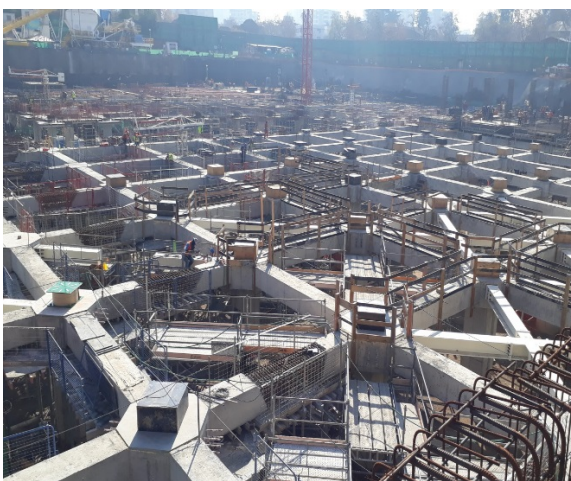
Sector ING. Avance en instalación de vigas metálicas, aisladores y vigas en hormigón
