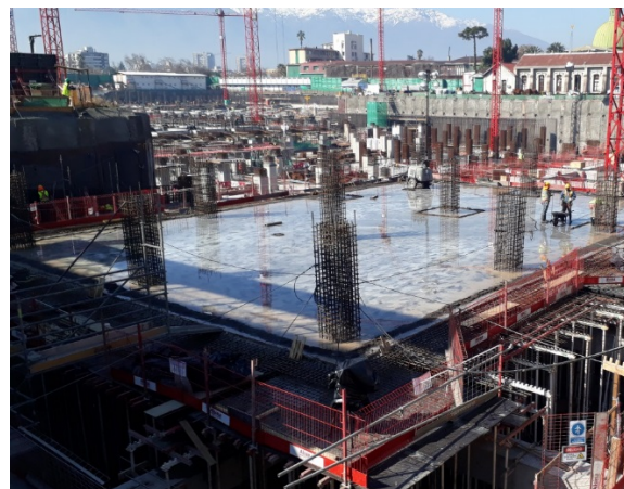
Sector AA. Avance en losa sobre aisladores. Muro perimetral e instalación de moldaje para vigas
