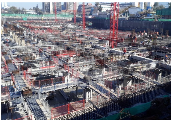
Sector HDS. Avance en instalación de moldaje y armadura para losa sobre aisladores
