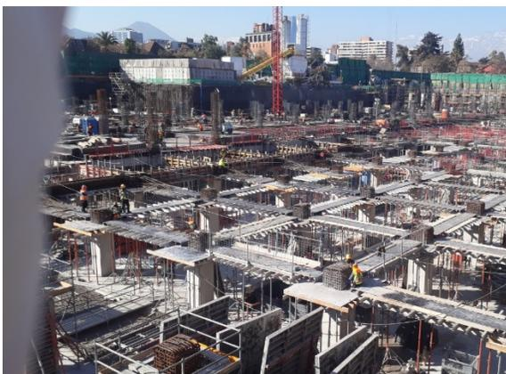
Instalación de moldaje y armaduras para vigas en hormigón. Área 6 del HDS. Atención cerrada
