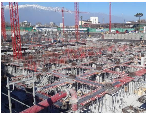
Instalación de fondo de viga y armadura de capiteles en área 3 del HDS. Atención cerrada
