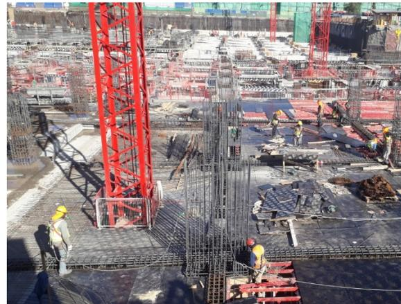
Instalación de moldaje para losa sobre aisladores en áreas 5 y 7 del HDS atención cerrada
