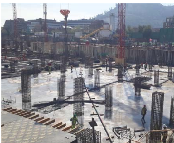
Losa de cielo del nivel -2 y trabajos de moldaje de losa de cielo del nivel -1. Área 8 en HDS
