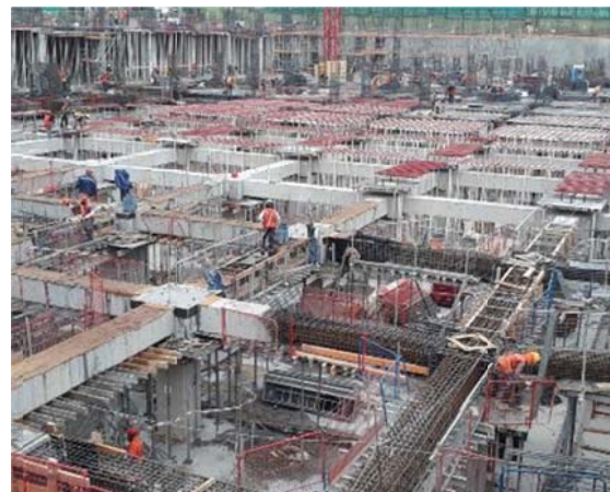
Instalación de moldajes y armaduras para vigas en hormigón. Áreas 7 y 8 en HDS. Nivel -2
