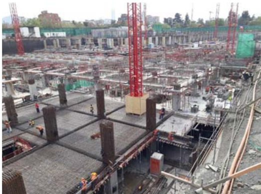
Moldaje para losa de cielo del nivel -3. Avance en preparación de vigas en hormigón. Áreas 4 – 5 y 6 HDS
