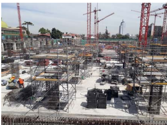
Preparación de armadura para pilares en el nivel 1 del ING. Área 10
