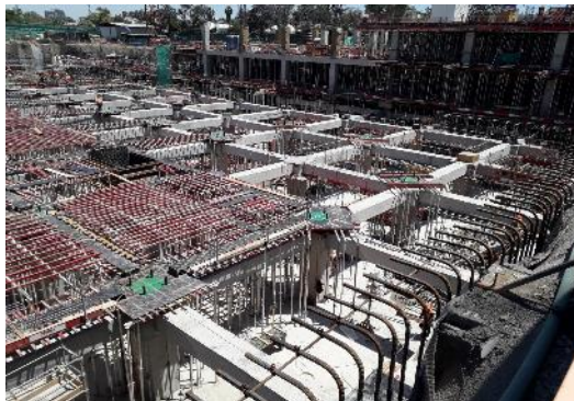
Área 3, Hospital Del Salvador (Trabajos en instalación de aisladores en nivel -2).
