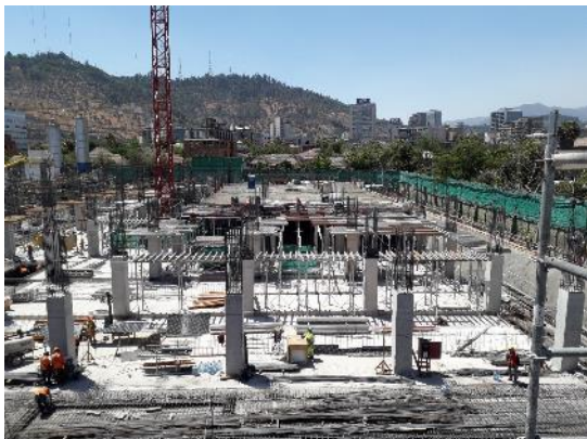
Área 8, Hospital Del Salvador (Hormigonado de losa y pilares, niveles 2 y 1 respectivamente).
