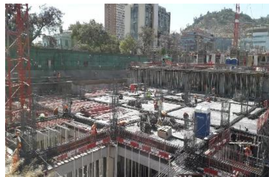
Área 2, Atención Abierta (Trabajos en vigas bajo aisladores de nivel -2).
