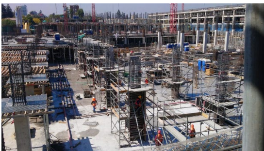
Área 1. AA Hormigón de pilares en área 5
