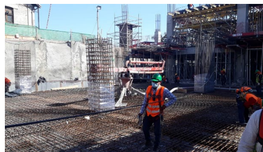
Área 3, HDS. Preparación de Losa en hormigón nivel -2 Instalación de moldaje y armadura.
