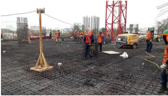
Área 2, AA. Preparación de Losa en hormigón nivel 3 Instalación de moldaje y armadura.
