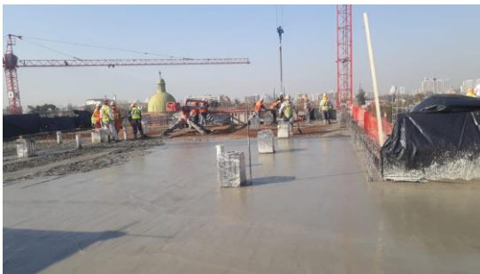
Área 1.AA. Hormigón losa cielo nivel 4. Piso Técnico.
