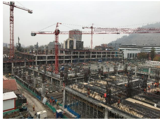
Avance del edificio HDS en Atención abierta y parte de atención cerrada
