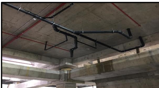
Instalación de ductos de alcantarillado en Nivel -2. HDS-AC
