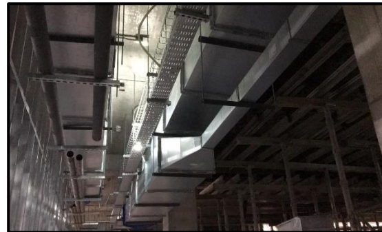
Instalación ductos de clima, bandejas eléctricas y canastillos de corrientes débiles. Perfiles de tabiquería. Nivel -1. ING
