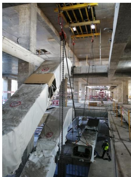
Instalación de escaleras mecánicas. Pisos -1, 1 y 2. AA
