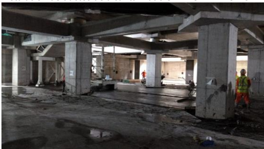
Hormigón de losa radier. Nivel -2. ING
