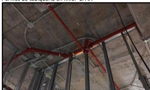
Instalación de tuberías de extinción de incendios. Nivel -1. AA.
