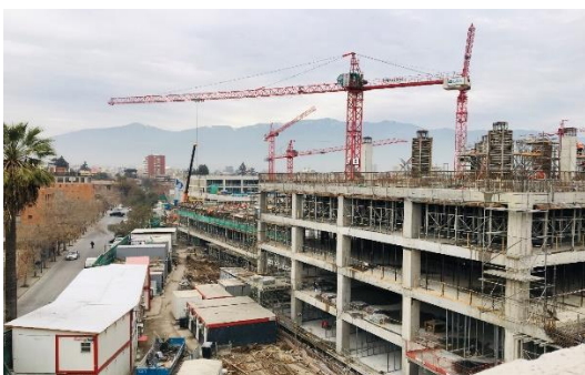
Avance en edificio HDS. Atención cerrada
