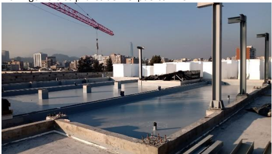
Trabajos de impermeabilización. Piso Técnico ING
