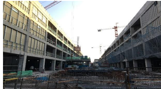
Avance en edificios ING y HDS
