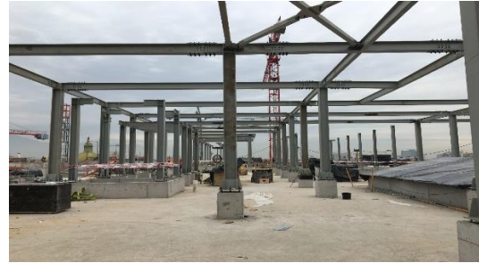
Pilares de acero en piso técnico. AA
