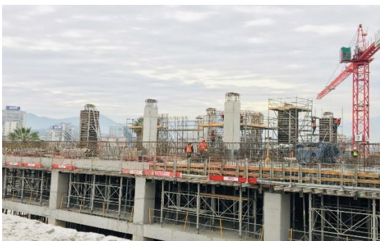
Hormigón de los pilares del helipuerto HDS
