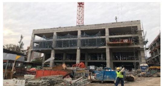
Avance en edificio AA
