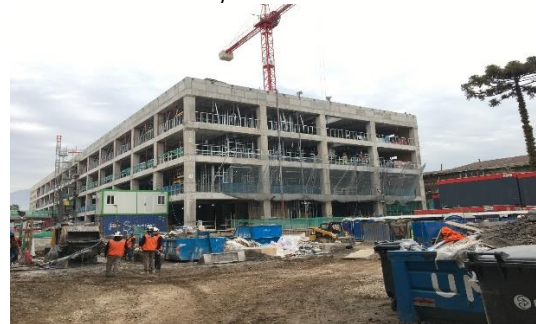
Avance del edificio ING
