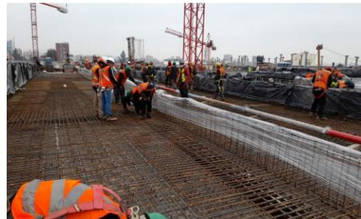
Edificio HDS. Cielo nivel 4. Enfierraduras de losa, capiteles y vigas
