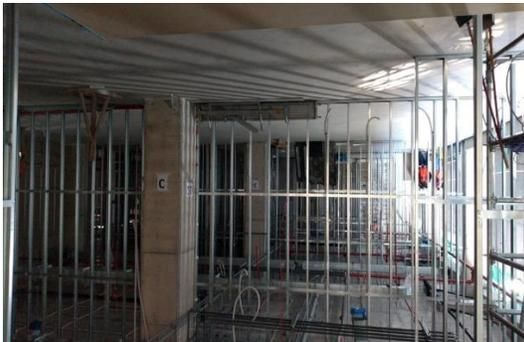
Edificio ING. Nivel subterráneo -1. Perfilería metálica tabiquería
