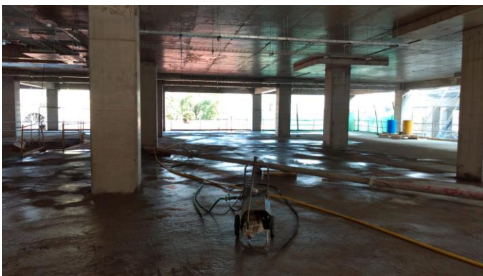
Recepcion de losa, edificio HDS piso 3.
