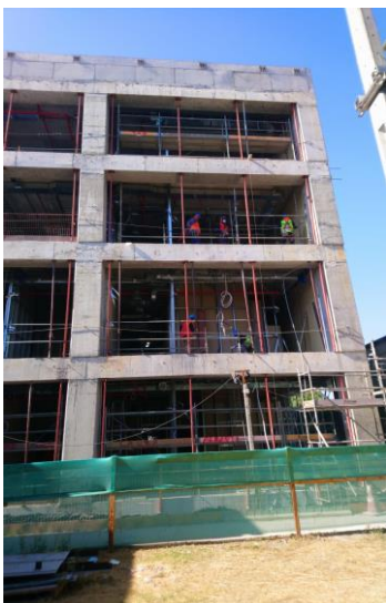
Revisión Estructura fachada, Edificio AA.
