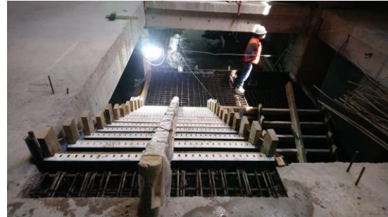
Escalera N°2, eje 6v.
