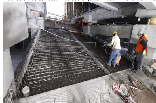
Armadura de rampa 4. HDS Nivel -2
