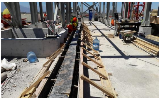
Instalación de armaduras para murete en canaleta piso técnico. Edificio Atención Abierta
