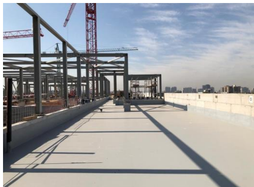
Impermeabilización de cubierta en piso técnico. Edificio AA
