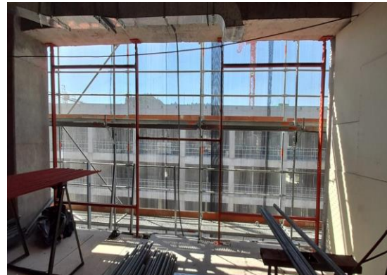
Instalación de perfiles metálicos para fachada. Edificio ING
