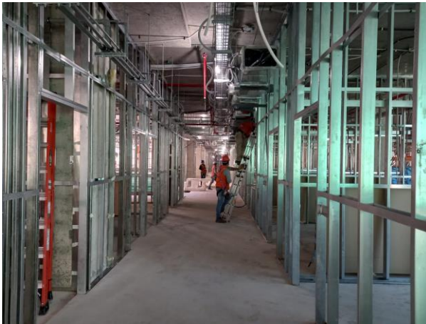
Estructuras tabiques de acero galvanizado, edificio HDS piso 2.
