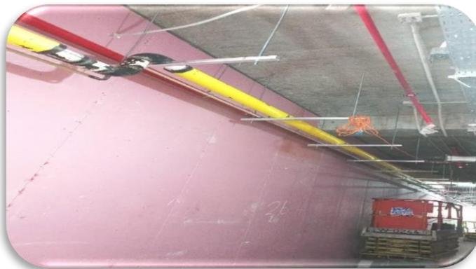
**Fotografía 2.** Soldadura de tuberías de gases clínicos, oxígeno, vacío, entre ejes 10-16/I-K, edificio HDS, piso S1.
