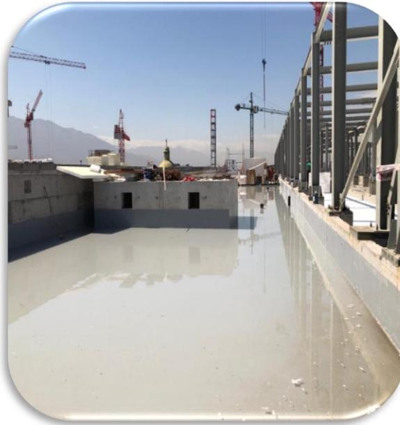
Fotografía 7. impermeabilización en cubierta plana no transitable (CUB-1) en AA entre ejes 4-5/Q-W, termino de prueba de estanqueidad.
