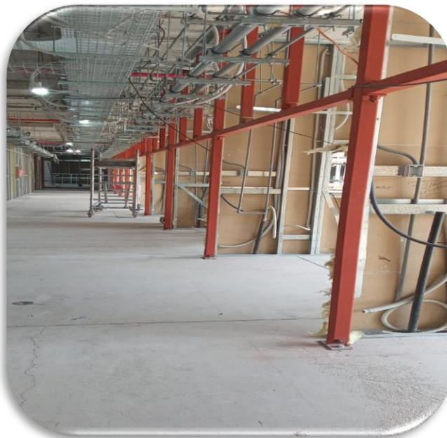
Fotografía 3. Estructuras metálicas de las puertas correderas entre los ejes 25/Q-M, 2° piso HDS
