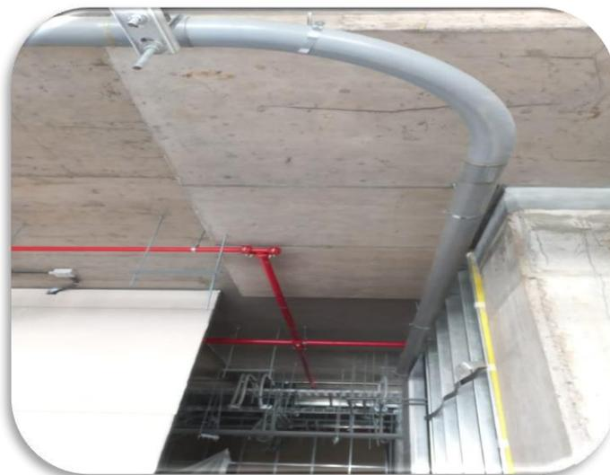
Fotografía 6. Montaje de tuberías de correo neumático, entre ejes 18-23/L-N, edificio HDS, piso 2.
