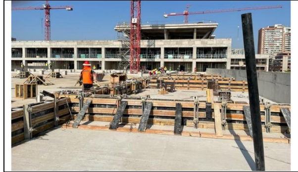
Instalación de armadura y moldaje en muretes y pedestales entre ejes T/V - 14/17 nivel 3 HDS
