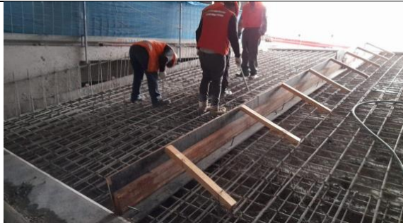
Enfierraduras superiores para Sobrelosa estriada rampa 4 entre S01 y S02, ejes 26-27/C-D
