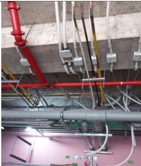
Montaje y soldadura de tuberías de gases clínicos, oxígeno, aire medicinal, vacío, entre ejes 17-26/I-K, edificio HDS, piso 2.
