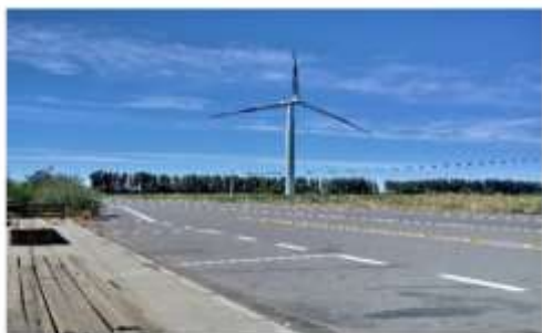
Ilustración N°6: Sector Parque Eólico
