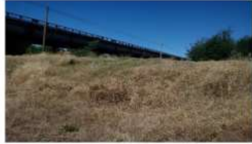
Ilustración N°2: Vista Lateral Puente Coihue
