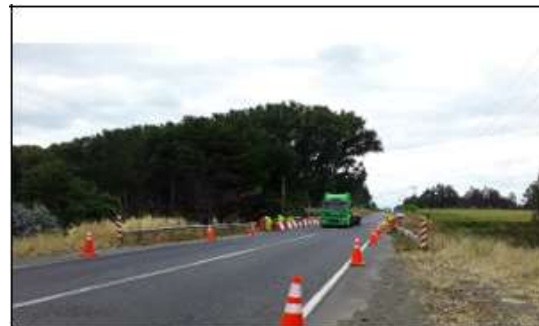
Ilustración N°6: Trabajos en Puente Coyanco
