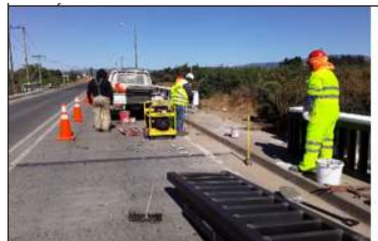
Ilustración N°5: Reposición de Barandas Puente Malleco
