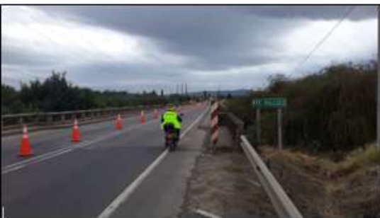
Ilustración N°2: Mantenimiento Puente Malleco
