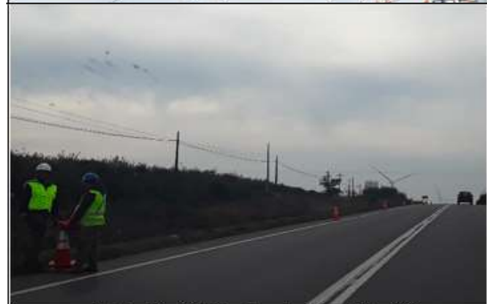
Ilustración N°4: Trabajos de Roce Ruta 180
