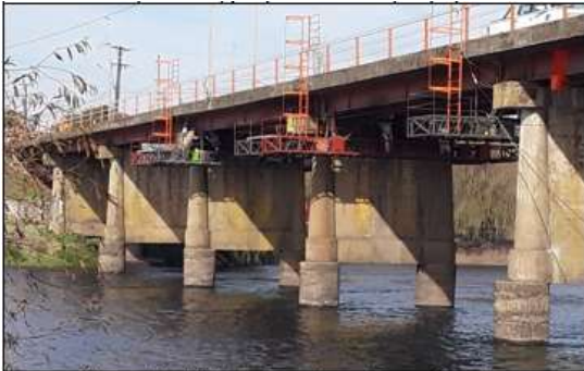
Ilustración N°5: Reforzamiento Puente Renaico
