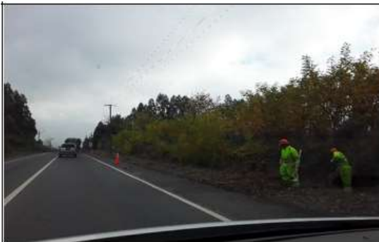
Ilustración N°6: Trabajos de Roce Ruta 180
