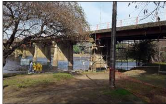
Ilustración N°3: Reforzamiento Puente Renaico
