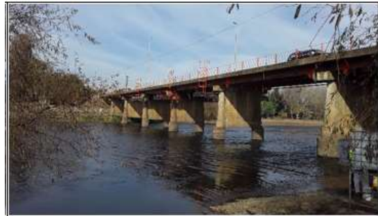
Ilustración N°2: Reforzamiento Puente Renaico
